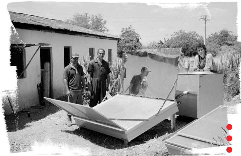
Teil der Solaranlage vor dem Küchengebäude in Santa Maria
